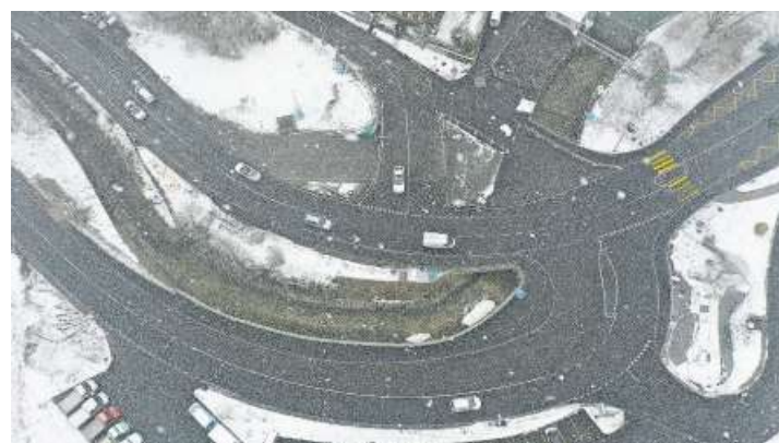
Der Knoten Schmittli ist bereit für die Strassensanierung.
