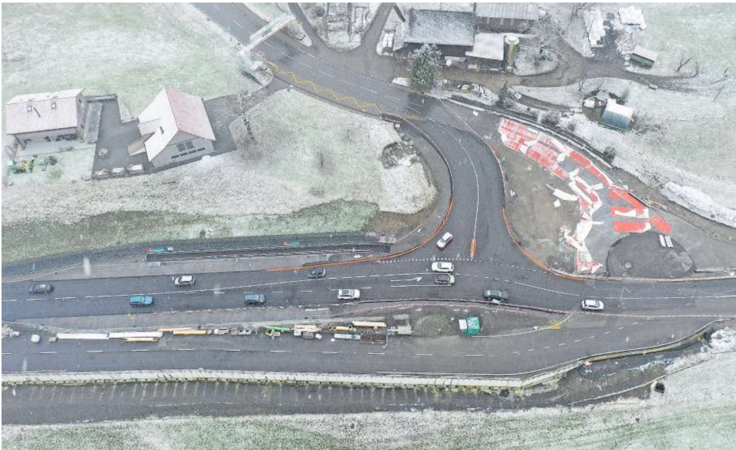
Der Knoten Nidfuren ist bereit für die Vollsperrung. Ab kommendem Montag wird der Verkehr hier umgeleitet.
