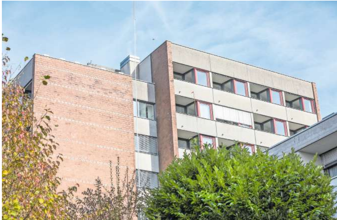
Die Liegenschaft (im Bild) kann nun abgebrochen werden.
