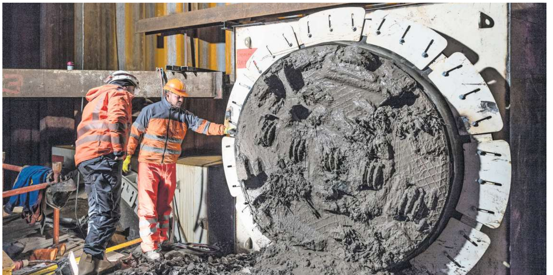
Mehrere Monate schon gräbt sich Bohrkopf Isabelle im Zuge des Projekts Circulago in Richtung Zugersee. Gestern nun erreichte er die Schützenmatt.
